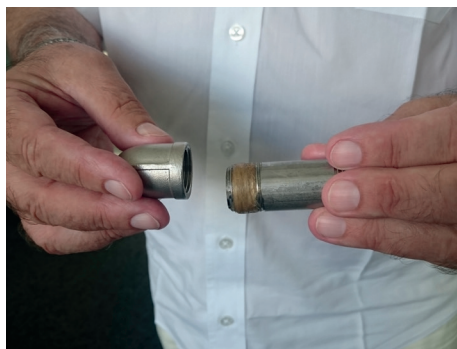
Gewinde einhanfen Enrober le filetage avec du chanvre Rivestire la filettatura canapa
